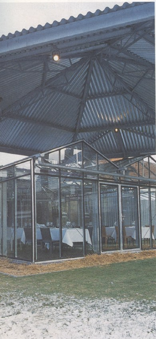
Het pand zit vol verwijzingen naar het agrarische verleden. Boven de serre hangt een in ere herstelde kap van een hooimijt.
